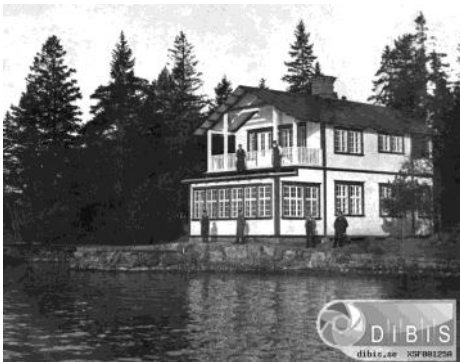
Käringnolaskär eller Hillmans holmen utanför Sandarne i Söderhamns skärgård. 1897-1913 uppförde Rickard Hillman, VD för AB Ad.F. Hillman, detta bygge. DIBIS XSFO0125
