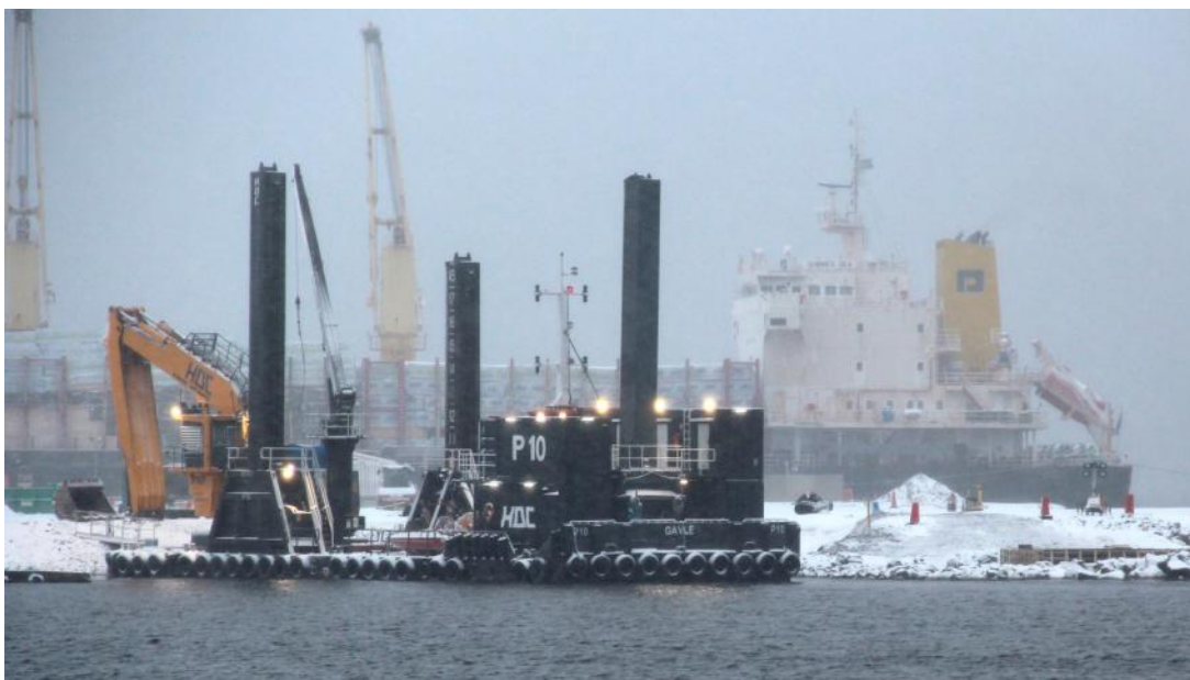
Muddringen av det tredje kajläget är i stort sett klar. Här är mudderverket från Gävle. I mitten på nästa år ska även kajbygget vara klart.
