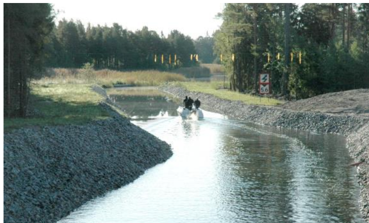
Rännan klar att tas i bruk i juni 2007. Riktning mot Norrfjärd.
