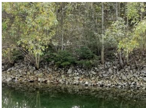
Sly och gran växer fort, rotsystemen spränger sönder kanterna. Detta måste snarast åtgärdas
